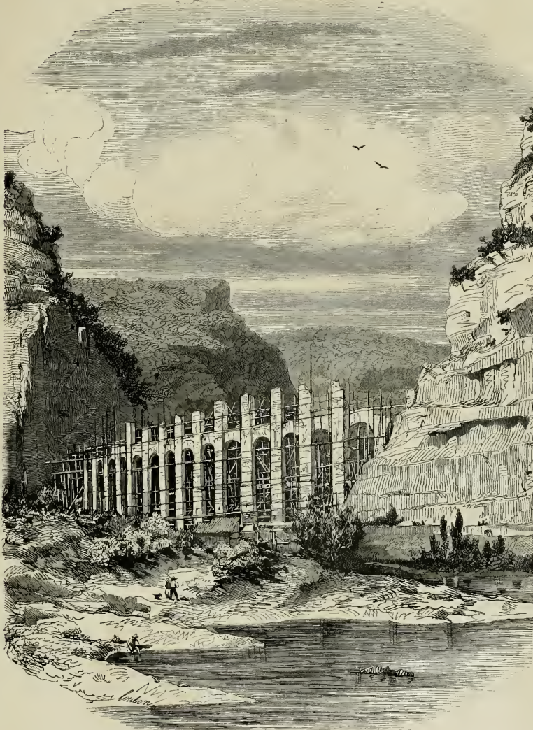
Aqueduc de Roquefavour. — État actuel des travaux.
