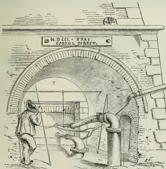
(Forges et fonderies de l'Aveyron. — Tuyère d'un haut fourneau.)
