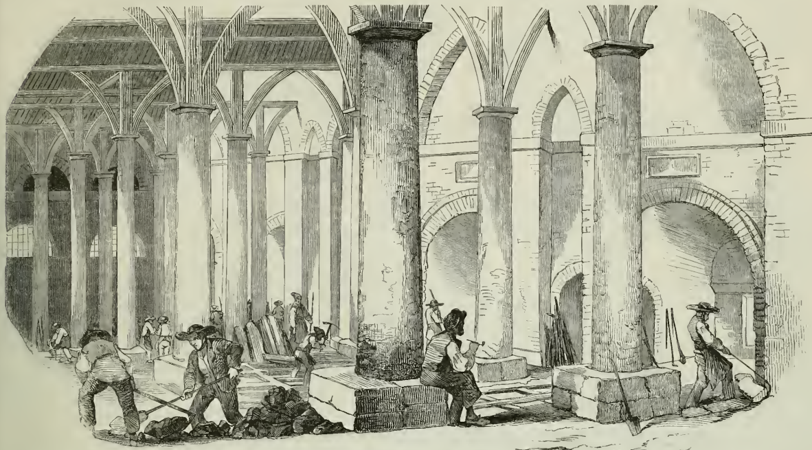
(Forges et fonderies de l'Aveyron. — Vue intérieure de la halle des hauts fourneaux.)
