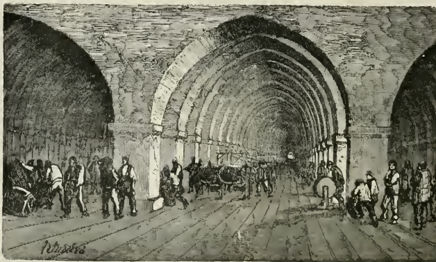
(Port de Toulon. — Ateliers de la corderie.)
