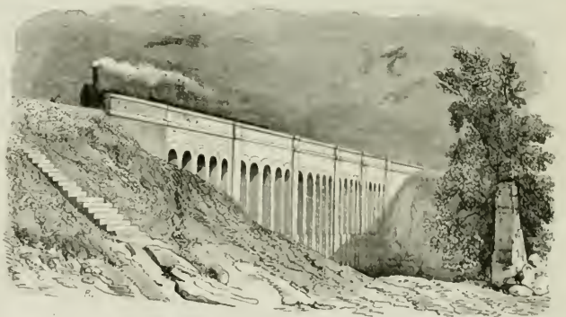
(Viaduc de Beaugency.)
