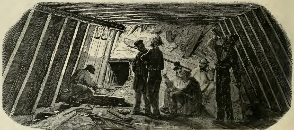
(Vue intérieure du tunnel de Courcelles après l'éboulement.)
