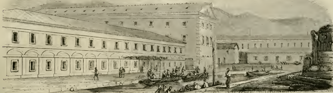
(Port de Toulon. — Vue extérieure de la garniture et du magasin général.)
