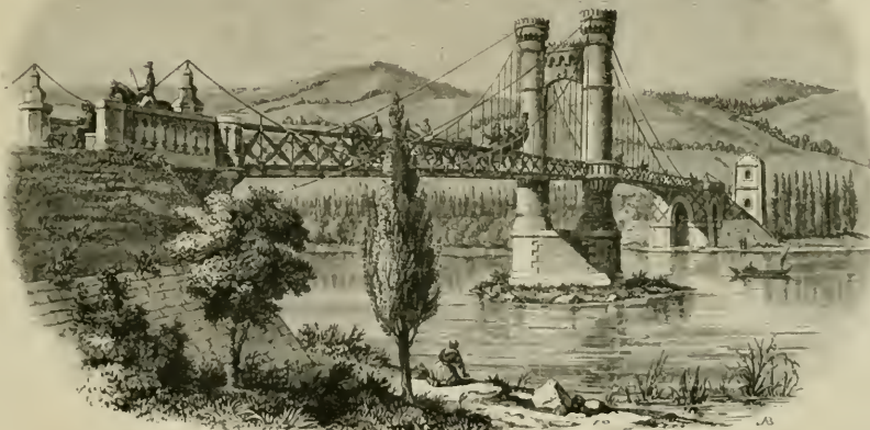
(Vichy. — Pont de Re o ur l'Allier, route de Vichy à Randan, construit par M. Boutand, ingénieur.)
