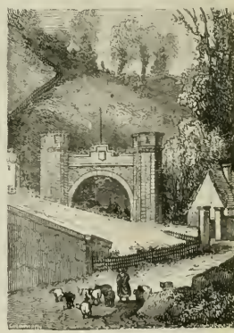
Tunnel de Youville.
