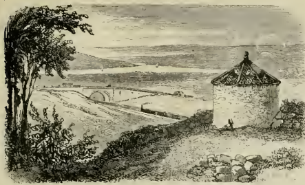
Un des puits couverts et l'entrée du tunnel de Rolleboise.
