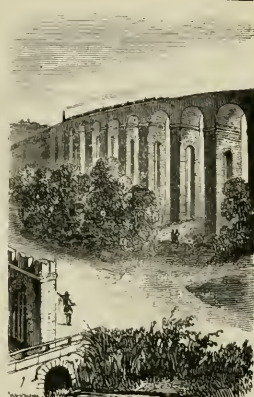
Partie courbe du viaduc de Mirville.
