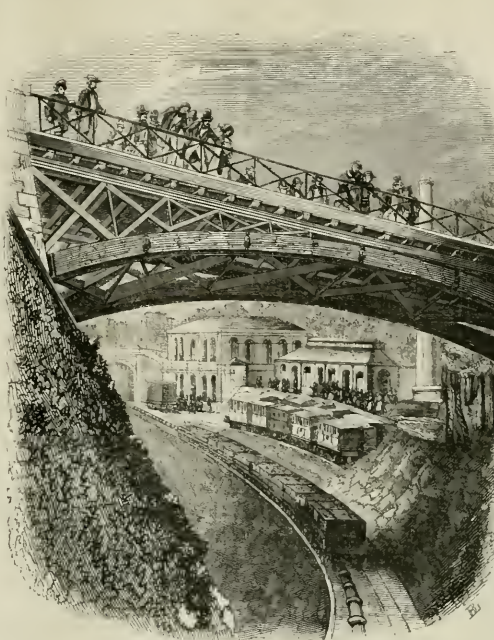
Chemin de fer atmosphérique. — Vue extérieure du bâtiment où se trouvent les machines.
