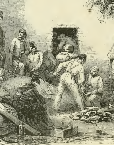
Démantèlement de Bapaume. — Sapeurs mineurs chargeant un fourneau de mine.
