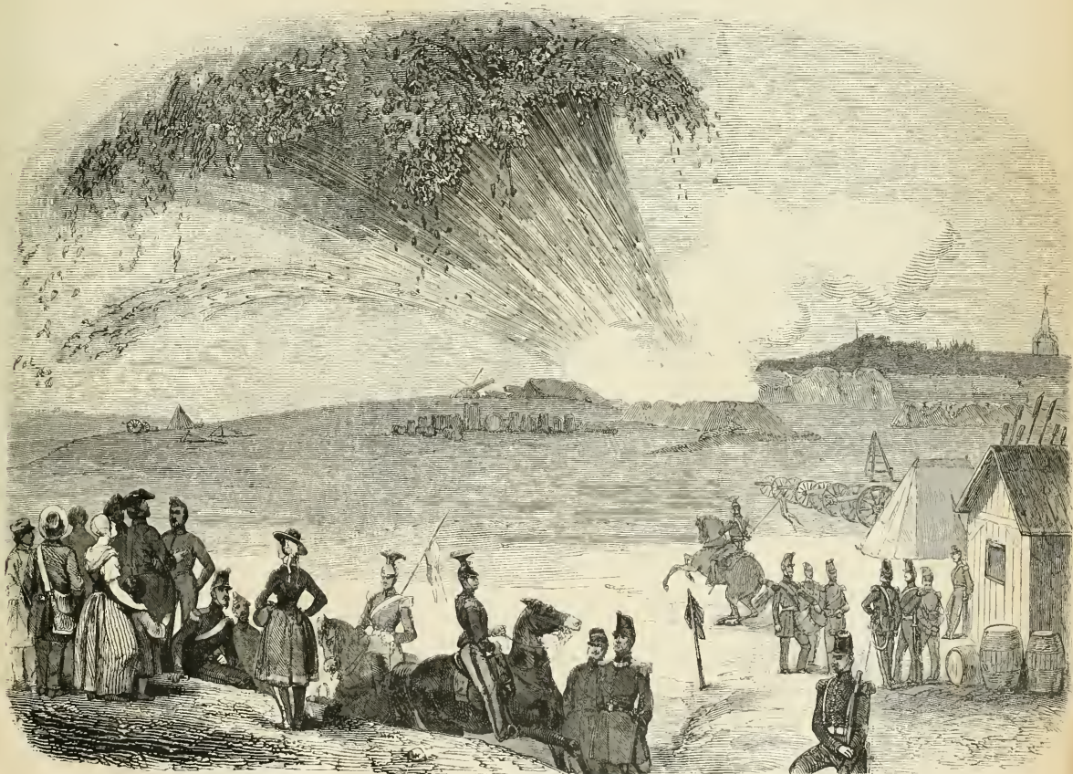
Démantèlement de Bapaume. — Débris d'une brèche pratiquée par la mine dans le bastion n o 6.
