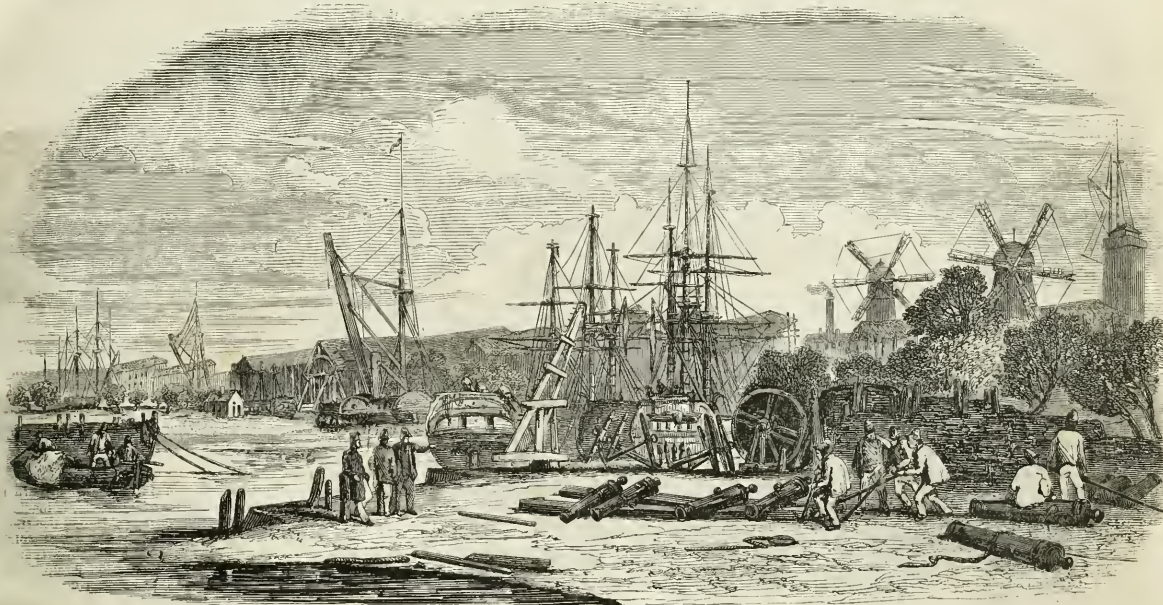
Vue générale du port de Rochefort prise de la Direction d'Artillerie de Marine (Porte du nord).
