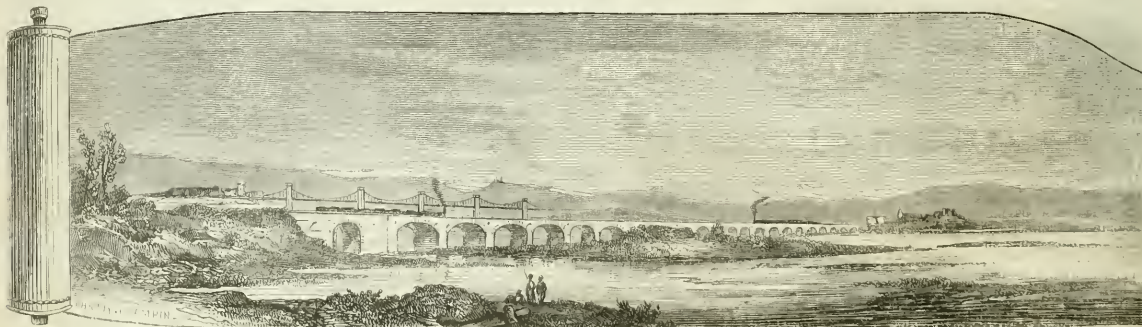
Chemin de fer d'Avignon à Marseille. — Viaduc de la Daranco, situé entre Avignon et Beaucaire.
