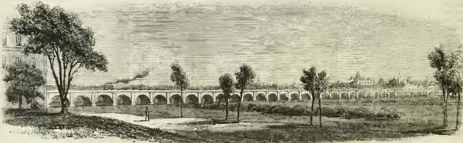
Chemin de fer d'Avignon à Marseille. — Viaduc d'Arles.
