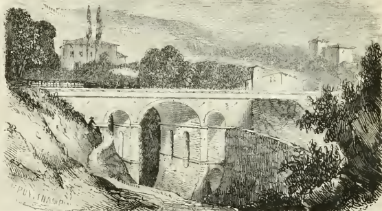
Chemin de fer d'Avignon à Marseille. — Viaduc des Ayalades.
