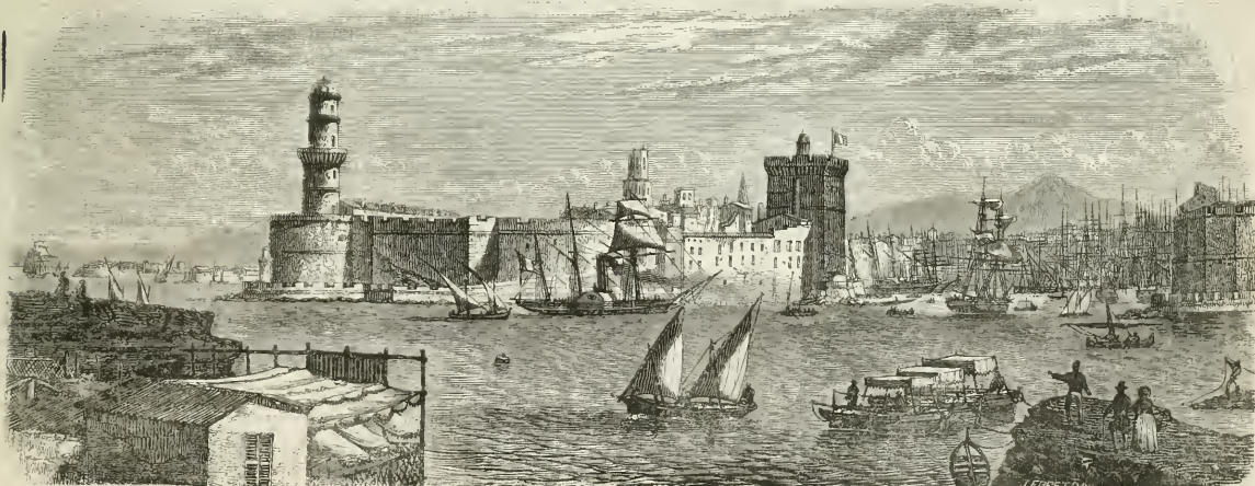
Chemin de fer d'Avignon à Marseille. — Vue de Marseille.
