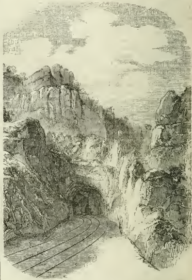
Chemin de fer d'Avignon à Marseille. — Entrée du tunnel de la Nerthe.
