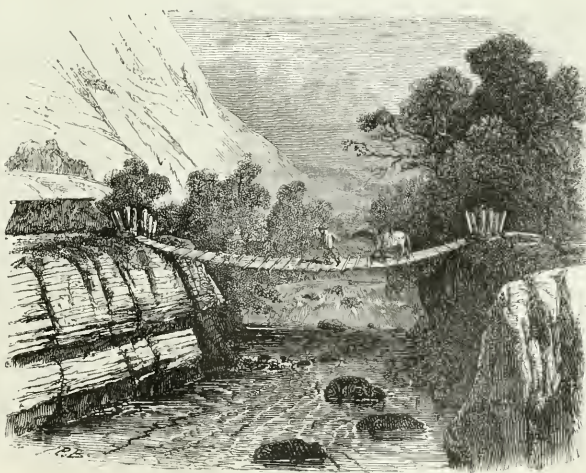
Amérique méridionale. — Pérou. — Pont d'osier sur la rivière de Quilabamba entre Pariscar et Ollantay-Tampu.
