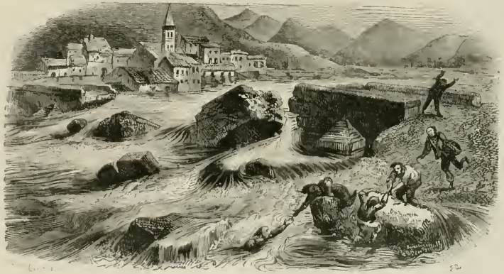
Inondations. — Le pont de Corp enlevé par le courant du tracé.
