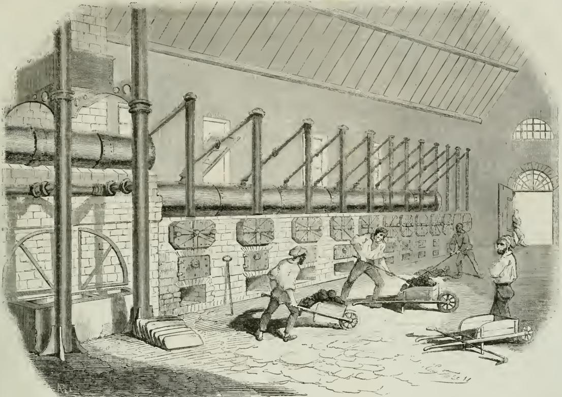
(Fabrication du Gaz. — Atelier de distillation.)
