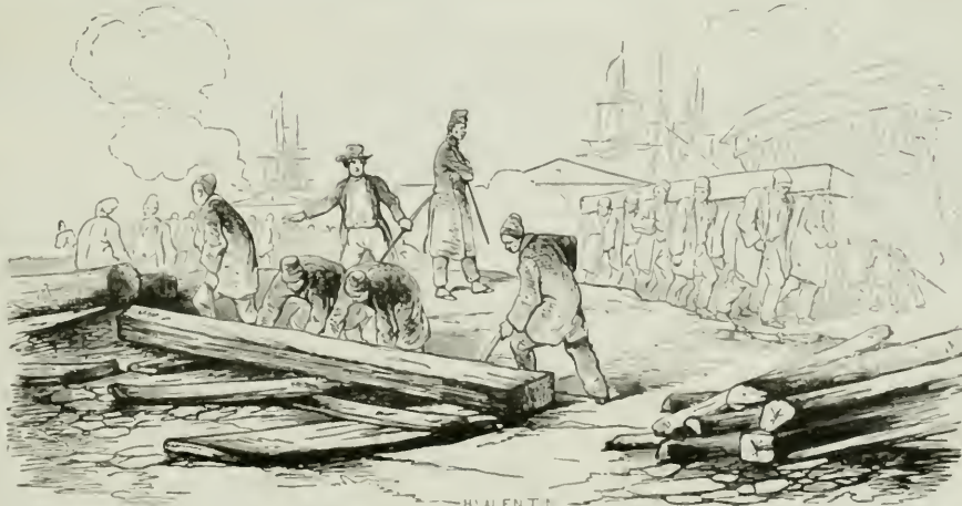
(Travaux des Forçats.)
